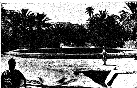
عين « الجويا » بواحة سيوة منظر يوضح المبنى المحيطة بمخرج العين وفتحة إحدى المسارات المنفرعة منها .
